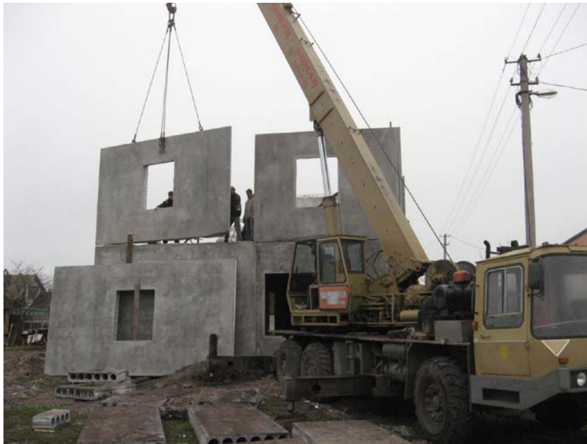
Dessin 1. L'installation des panneaux à trois couches
