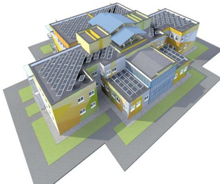
Dessin 2. La conception de l'école maternelle construite des panneaux à trois couches.
